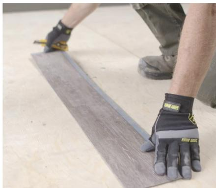
Pour couper une planche, il suffit de mesurer et de marquer la planche, puis d'utiliser une règle droite et un couteau à lame rétractable pour entailler la planche avant de casser cette dernière.
