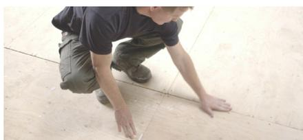
Le revêtement de sol GripStrip Allure peut être installé sur la plupart des revêtements de sol existants, mais il faut d'abord s'assurer **que le sous-plancher est lisse, plat, sec, propre et solide.**
