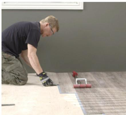
Il est également nécessaire de décaler les joints entre les planches et les joints d'extrémité d'au moins 15,24 cm (6 po) afin d'obtenir une apparence plus naturelle.
