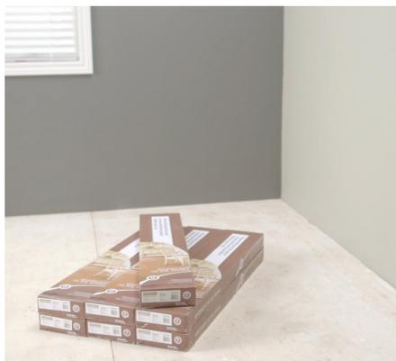
**Déposez d'abord les boîtes de planches fermées** dans la pièce où s'effectuera la pose au moins deux jours avant le début des travaux afin que les planches s'acclimatent à la température et à l'humidité.
