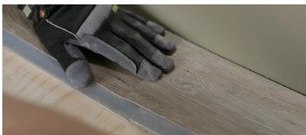
Pour emboîter deux planches, inclinez la seconde planche dans le rebord correspondant à un angle de 45°. Le rebord supérieur s'insère toujours dans le rebord inférieur. En commençant par une extrémité de la planche, servez-vous d'une main pour maintenir la planche et de l'autre pour fixer les rebords en place.
