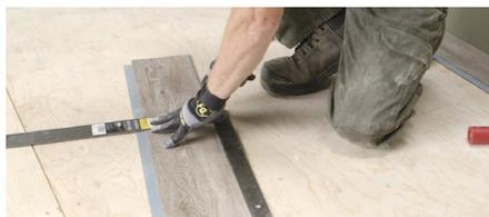
Commencez la deuxième rangée avec une planche coupée aux deux tiers de sa longueur. Pour couper une planche, il suffit de la mesurer, de la marquer, de l'entailler et de la casser. Le rebord supérieur s'insère dans la première rangée. À nouveau, placez un coin de la planche contre l'autre et faites rouler la planche solidement en place à un angle de 45°.
