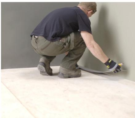
En commençant par un coin, installez la première rangée de façon à ce que le rebord inférieur soit placé vers la pièce, en laissant un écart d'au moins 3,17 mm ( $\frac{1}{8}$  po) pour l'expansion. Cet écart devrait être dissimulé par la moulure. Coupez le côté long du rebord supérieur faisant face au mur. Assurez-vous de couper le rebord supérieur sur toute la longueur de la première rangée ainsi que sur le côté court de la première planche.
