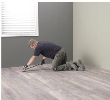
Une fois la pose terminée, nous conseillons de passer un rouleau de plancher sur les joints, dans les deux directions, afin de s'assurer que les rebords adhésifs sont bien collés.
