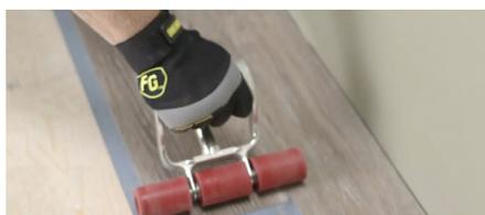
Une fois les planches bien en place, utilisez un rouleau manuel directement sur le joint et exercez autant de pression que possible afin de coller le joint sans laisser d'écart visible entre les planches. Si votre joint n'est pas serré, soulevez lentement la planche du dessus afin de la retirer et replacez-la correctement avant de passer le rouleau.
