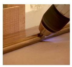
Enfoncez des clous à plancher dans les languettes des planches et utilisez un chasse-clou pour éviter que les têtes des clous ne fassent saillie. Poursuivez en plaçant et clouant une à une les planches au sol.
