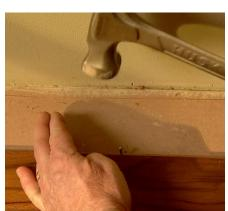
Placez la dernière rangée et insérez les cales entre le mur et la dernière rangée de planches. Resserrez les deux dernières rangées à l'aide d'un levier appuyé sur les cales de façon à ne pas abîmer le mur. Prépercez des trous dans les planches et le sol. Puis, clouez les dernières planches.
