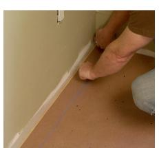
Mesurez la largeur d'une planche et ajoutez-y la dimension de l'espace nécessaire pour l'expansion, puis marquez le papier à plusieurs endroits le long du mur de départ. Utilisez les marques tracées sur le papier de construction pour tracer une ligne droite au cordeau. Vous poserez sur cette ligne la languette de la première rangée de planches. Il est très important que la première rangée soit droite car la totalité de l'installation en dépend.
