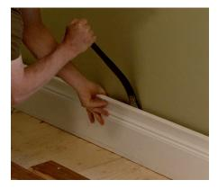
Retirez les plinthes de la pièce à l'aide d'un levier. Faites attention de ne pas endommager les plinthes si vous souhaitez les réinstaller.
