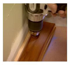
Alignez la première rangée le long de la ligne faite au cordeau de façon à ce que la languette soit face à la pièce, et percez des trous à 30,48 cm (12 po) d'intervalle, à travers les planches et le sol. Enfoncez ensuite des clous à plancher annelés de 5,08 cm (2 po) dans les trous.
