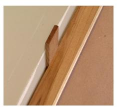
Insérez des cales entre le mur et la première rangée de planches. Les planches en bois de feuillus se dilatent avec l'humidité, il est donc nécessaire de laisser un espace de dilatation de l'épaisseur de votre planche le long du périmètre de la pièce. Par exemple, pour des planches de 1,90 cm (¾ po) d'épaisseur, laissez un espace de 1,90 cm (¾ po). Les cales doivent être retirées une fois l'installation terminée. Les plinthes dissimuleront cet espace.
