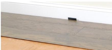
Une fois que la première rangée repose contre le mur, les côtés languette et rainures s'emboîtent vers l'intérieur de la pièce. Démarrez la deuxième rangée avec la partie de la planche que vous avez coupée à l'extrémité de la première rangée, si elle mesure plus de 30,48 cm (1 pi). Si ce n'est pas le cas, démarrez la rangée avec une planche coupée à une longueur supérieure à 30,48 cm (1 pi).
