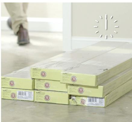
Déposez les boîtes de planches fermées dans la pièce où s'effectuera la pose au moins deux jours avant le début des travaux afin que les planches s'acclimatent à la température et à l'humidité.
