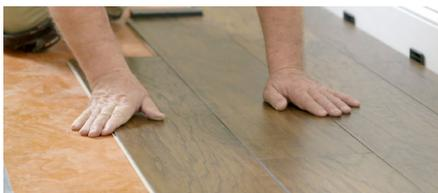
Il est également nécessaire de décaler les joints afin d'obtenir une apparence plus naturelle. Les joints doivent être décalés d'au moins 30,48 cm à 40,64 cm (12 po à 16 po) par rapport aux joints adjacents.
