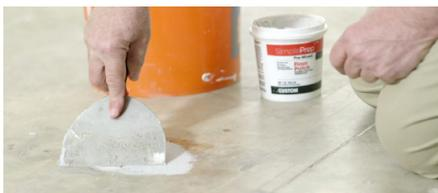
Les sous-planchers doivent être résistants, plats et propres. L'utilisation d'un pare-vapeur est nécessaire pour une installation sur du béton, sous le niveau du sol ou dans une pièce très humide. Si vous remplacez un revêtement de sol installé avant 1990, contactez un professionnel préalablement à la pose.
