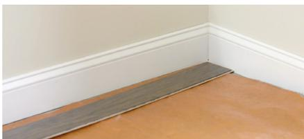
Commencez à installer vos rangées. Le côté languette des planches de la première rangée reposer contre le mur. À l'extrémité de la première rangée, coupez la planche à la longueur nécessaire pour terminer la rangée. Laissez toujours un écart de 0,95 cm à 1,58 cm (3/8 po à 5/8 po) à chaque extrémité pour tenir compte de l'expansion du sol.
