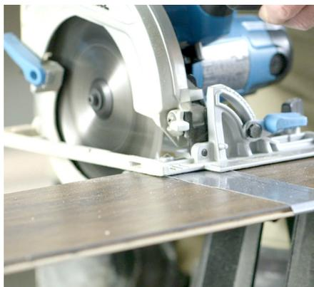
Ensuite vous devrez couper les planches à l'aide d'une scie circulaire fixe, d'une scie à onglet, d'une scie circulaire ou d'une scie à main. Comme les moulures couvriront les rebords, la coupe n'a pas à être parfaite.
