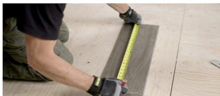
Pour couper une planche, il suffit de mesurer et de marquer la planche, puis d'utiliser une règle droite et un couteau à lame rétractable pour entailler la planche avant de casser cette dernière.
