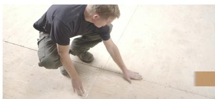
Un des grands avantages du revêtement de sol à emboîtement en vinyle est qu'il peut être installé sur la plupart des revêtements de sol existants avec une préparation minimale, mais il faut d'abord s'assurer que le sous-plancher est lisse, plat, sec, propre et solide.
