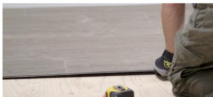
Commencez la troisième rangée **avec une planche coupée à un tiers de sa longueur (40,64 cm [16 po])**. La partie restante pourra être utilisée à l'autre bout de la rangée si la disposition de la pièce le permet.
