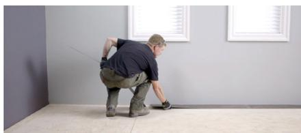
À partir d'un coin de la pièce, disposez une rangée de planches sans les emboîter afin de déterminer si vous devez ajuster la longueur de la première planche de façon à éviter de terminer avec un morceau de moins de 30,48 cm (12 po) à l'autre bout de la rangée. La dernière planche doit être de la même longueur que la première.
